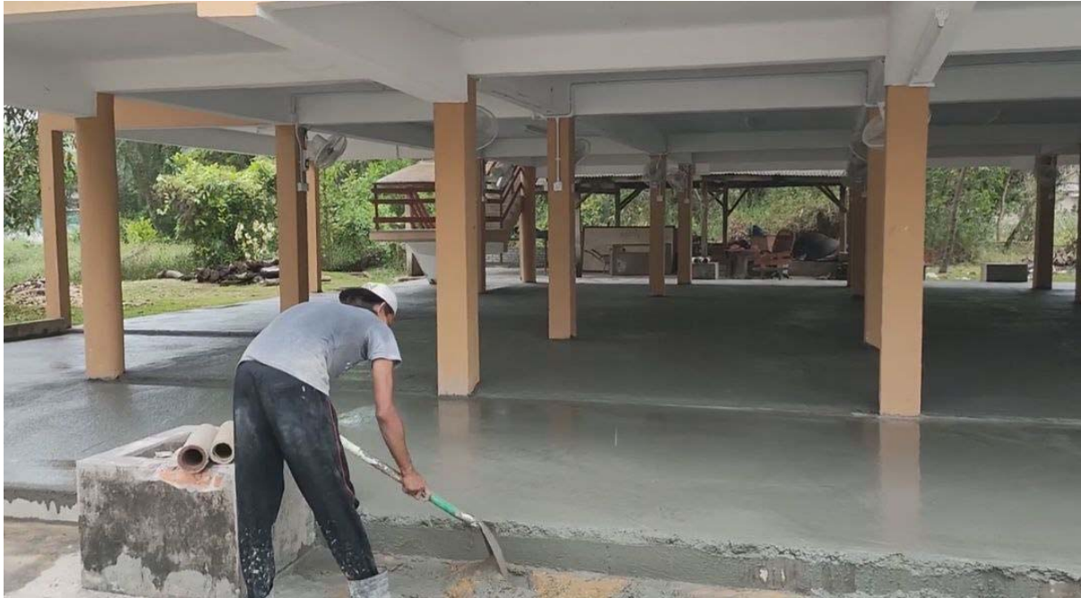
Kerja-kerja menaiktaraf sedang dijalankan
