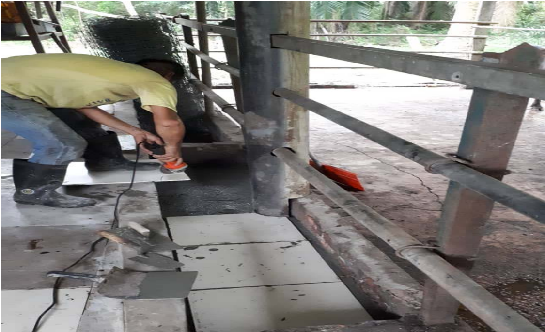
Pekerja membaik pulih palong lembu yang rosak
